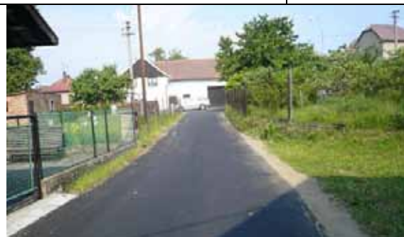
Obec Perálec , „Stavební úpravy stávající místní komunikace v obci Perálec“
