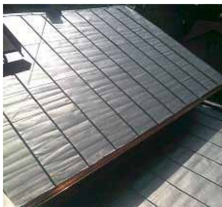
Tělocvičná jednota Sokol Proseč, „Obnova nátěru střechy a výměna okapů na budově sokolovny“
