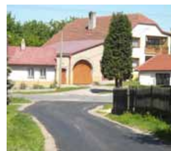
Obec Bohuňovice , „Oprava místní komunikace v obci Bohuňovice“
