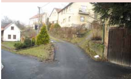
Obec Janov , „Oprava povrchu místní komunikace“
